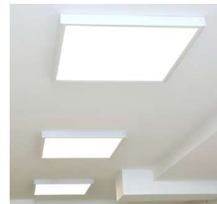
Lắp đặt ốp nổi
