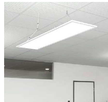
Lắp đặt thả trần
